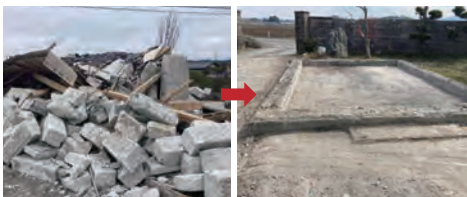
被害を受けた家屋やブロック塀の瓦礫を、重機により次々撤去。画像はそれぞれ、左が作業前・右が作業後。
