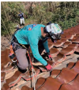
足元も不安定な急勾配の屋根の上で、ハーネス (命綱) を装着しての修繕活動。
