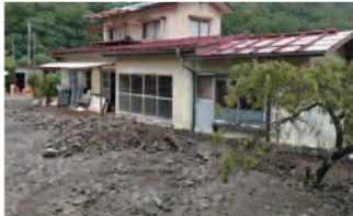
（左）土砂が厚く堆積した辰野町の被災現場。
