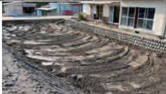
（右）土砂の撤去作業により、現場が復旧。
